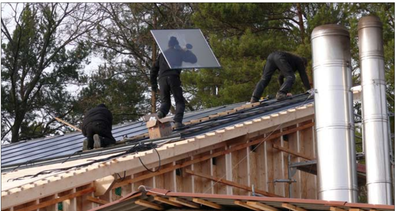
Men in black oder SEK? Alles falsch: es sind die Monteure für die Solarthermie auf dem neuen Dach der Holzhack-schnitzelhalle im ZEGG.
