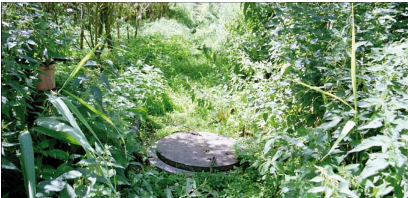
Ein üppiges Biotop: sommerlicher Blick in unsere Pflanzenkläranlage.
